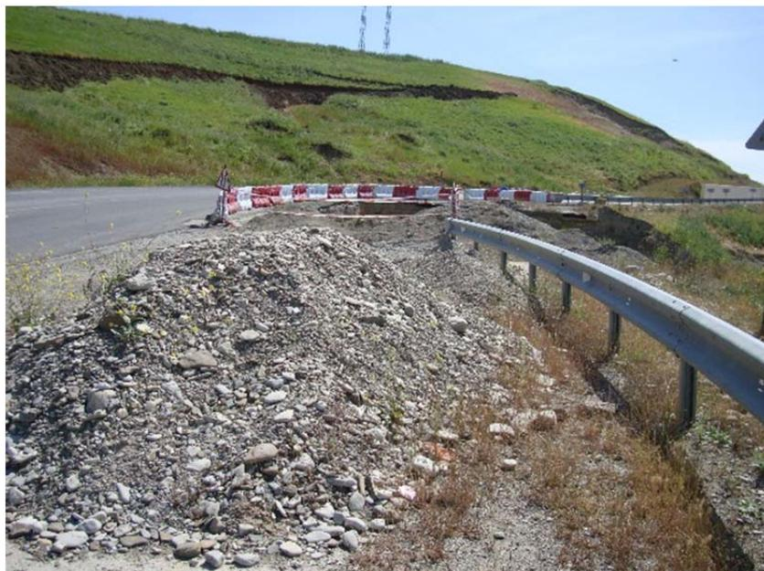
Рисунок 2 – Оползневые процессы на 106 км автодороги Баку–Гобустан–Шемаха
