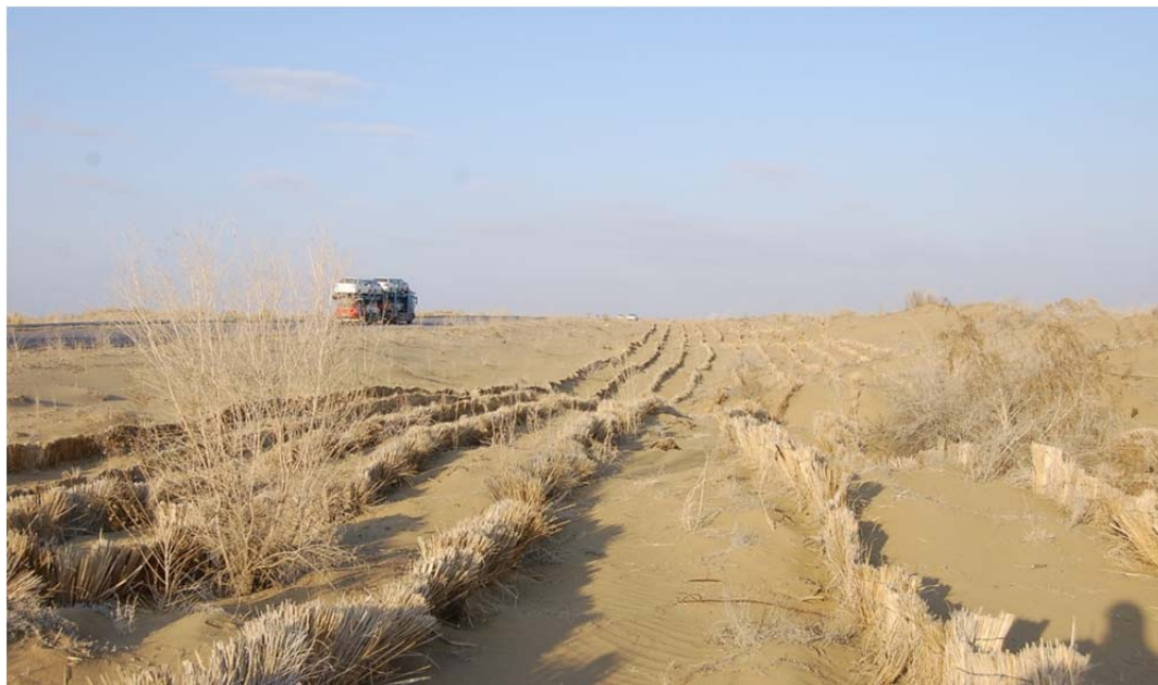
Рисунок 3 – Проведение фитомелиоративных работ с комбинированной установкой рядовых полускрытых механических защит вдоль автомобильной дороги
