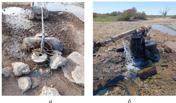
Рисунок 3 – Оголовок водозаборной скважины (а) и зона санитарной охраны (б) Figure 3 – Water intake well head (a) and sanitary protection zone (b)
