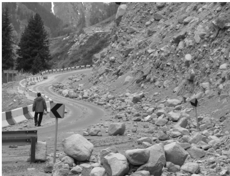
2-сурет – Құмбел өзенінің (Үлкен Алматы өз. оң саласы) таудан шыға берістегі оң беткейіндегі флювийгляциальды түзілімдердің жер сілкінісінен соң жолды бөгеген көрінісі (Гляциолог Н. Косаткин жер сілкіну алдында осы аумақта бір аптаға тақау жауын жауғанын айтты)
