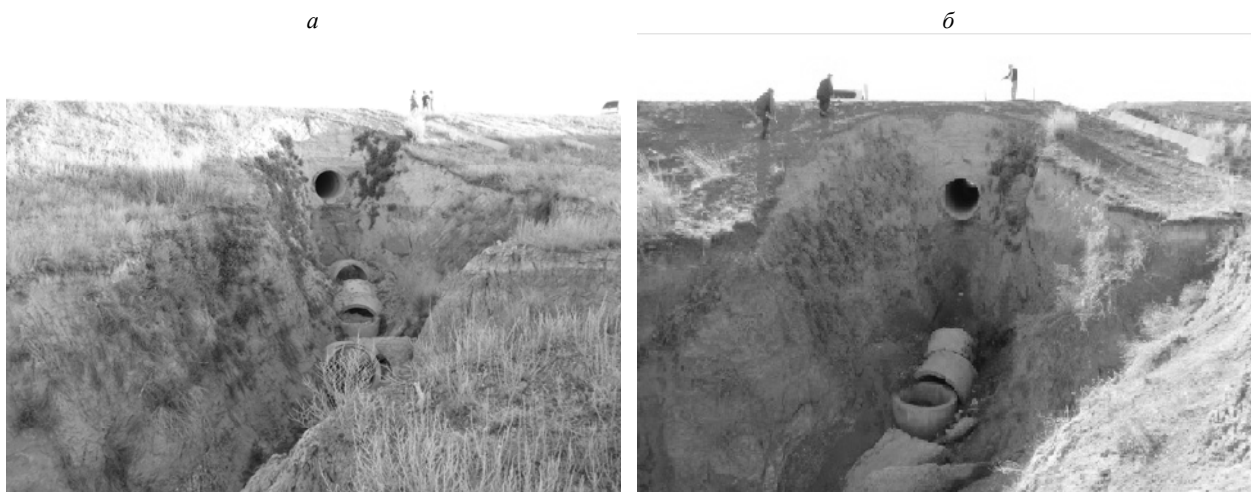
1-сурет – Сарыөзек–Қорғас автожолының 1,9 км-дегі бетонды көпірдің жыраларға ұласуы: а – 2013 ж., б – 2014 ж.
