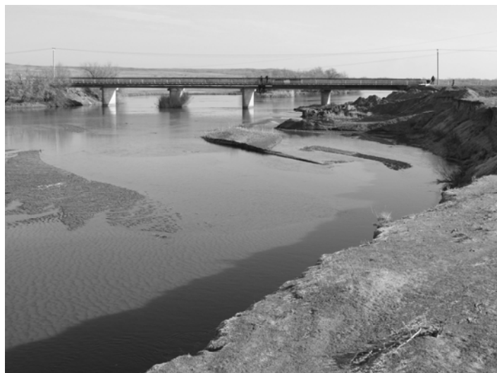
6-сурет – Лепсі өзеніндегі Көктерек ауылының көпіріне бүйірлік эрозия үдерісі қауіп төндіруде
