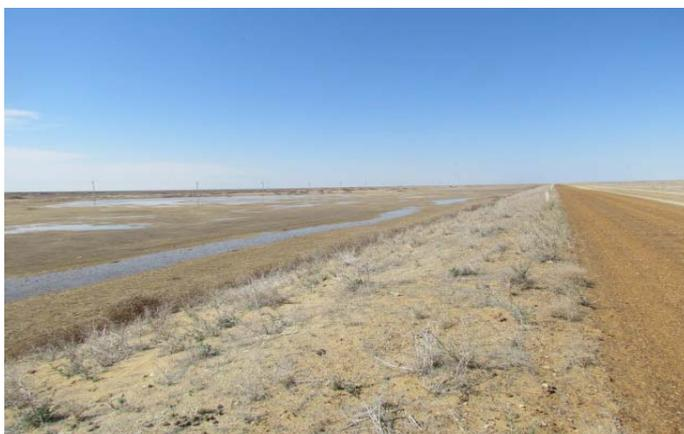
Рисунок 5 – Инфильтрационные процессы в насыпной защитной дамбе
