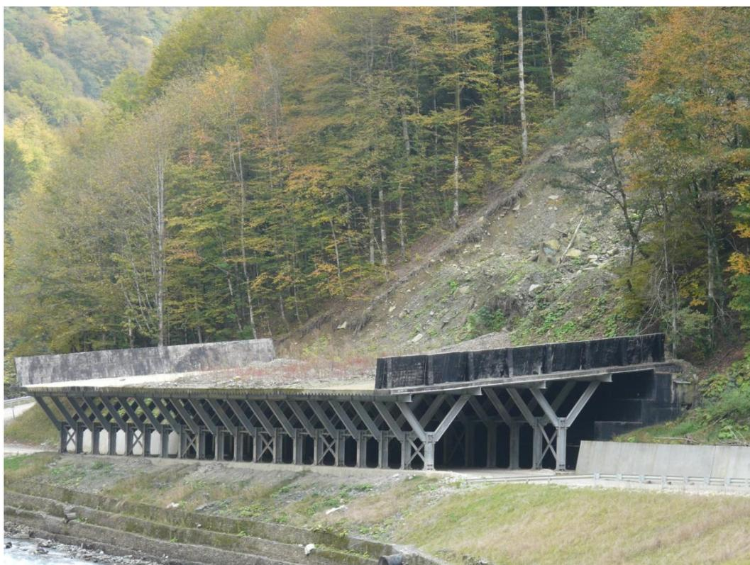
Рисунок 2 – Галерея открытого типа, построенная в долине р. Мзымта вблизи горнолыжного центра «Роза Хутор» (район Красной Поляны) для защиты автомобильной федеральной трассы от селевых потоков. Фото Ю. Ефремова. Сентябрь 2016 г.
