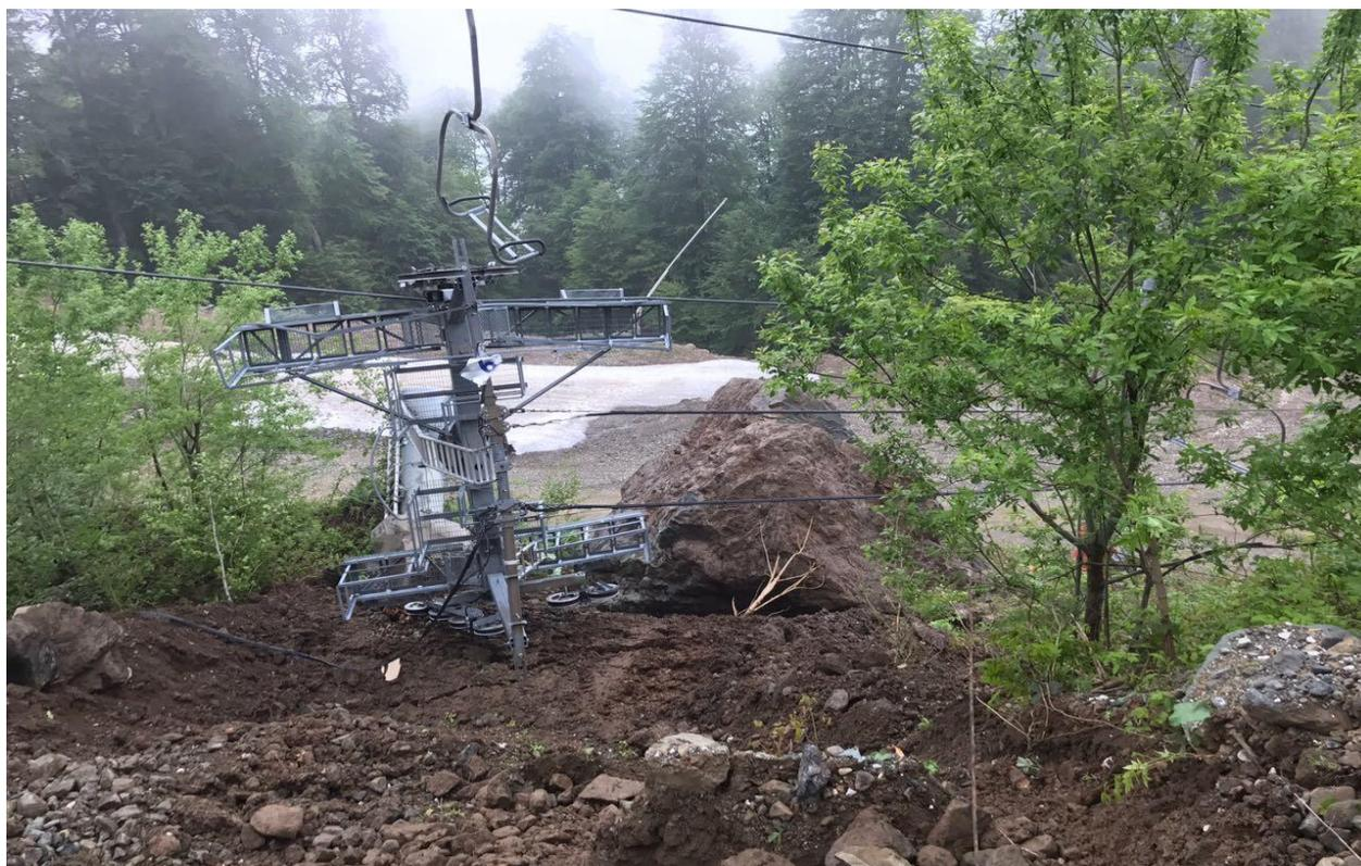
Рисунок 4 – Оползень и селевой поток в январе 2017 г. разрушили канатно-кресельную дорогу и уничтожили техническую дорогу на горнолыжном центре «Русские горки» в районе Красной Поляны (курорт «Большой Сочи»). Фото А. Цмокана
