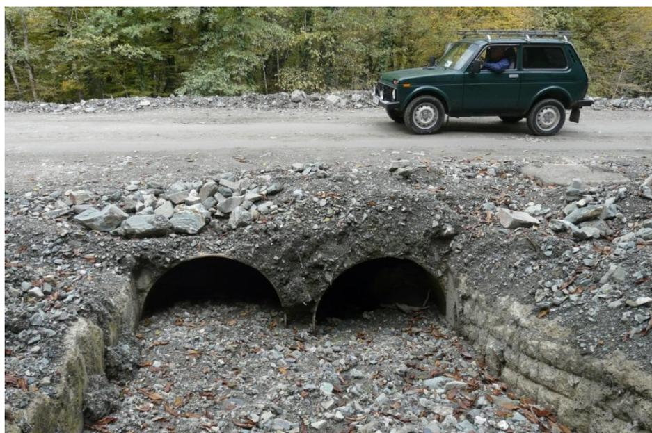
Рисунок 6 – В селевых руслах в бассейне р. Мзымта происходит закупоривание дренажных труб селевыми отложениями.
