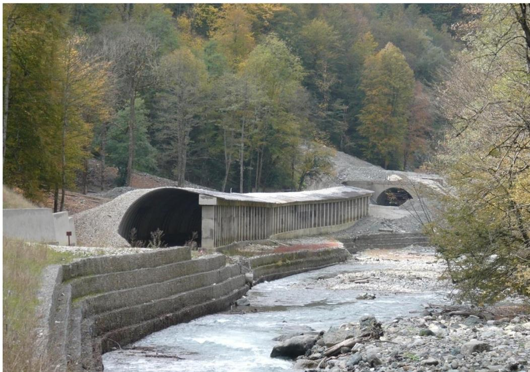
Рисунок 1 – Противоселевые галереи открытого и закрытого типа для защиты федеральной автомобильной трассы в долине р. Мзымта. Фото Ю. Ефремова. Сентябрь 2016 г.
