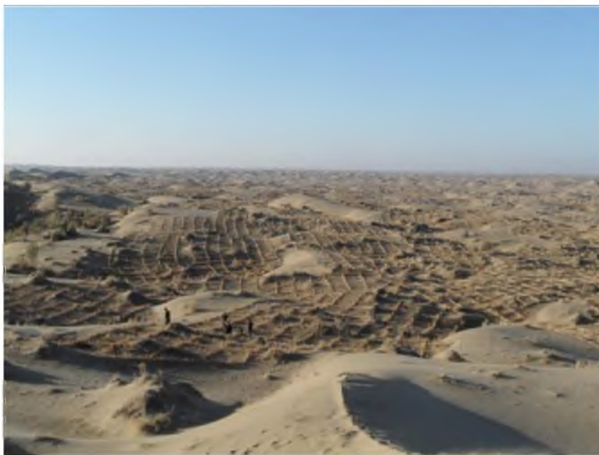
Рисунок 3 – Закрепление барханных песков механическими заплатами
