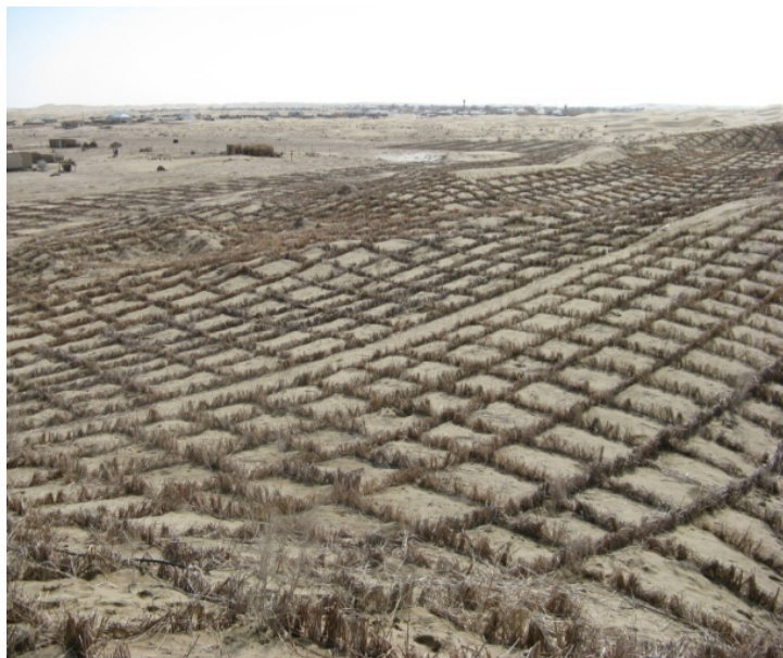
Рисунок 2 – Полная блокировка подвижных барханов клеточными защитами
