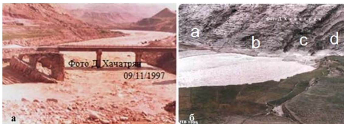
Рисунок 4 – Река Марун около моста Поле-Дохтар спустя 4 дня после проливных дождей 05.11.1997 г. (а) и место слияния рек Марун и Джен (б). На рисунке а видны остатки древнего моста Поле-Дохтар и незавершенного бетонного моста. Даже следов от разрушенного селевым потоком моста не осталось
