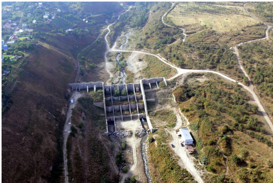
Рисунок 1 – Селезащитная плотина в русле р. Каргалы
