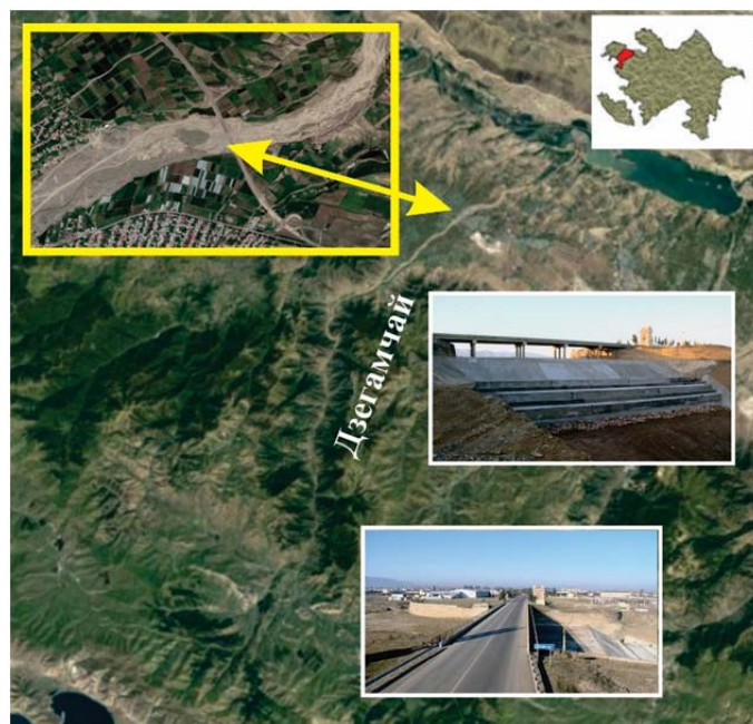
Рисунок 2 – В результате селя мост через р. Дзегамчай пришел в негодность и часть трассы была затоплена (13 июня 2021 г.)
