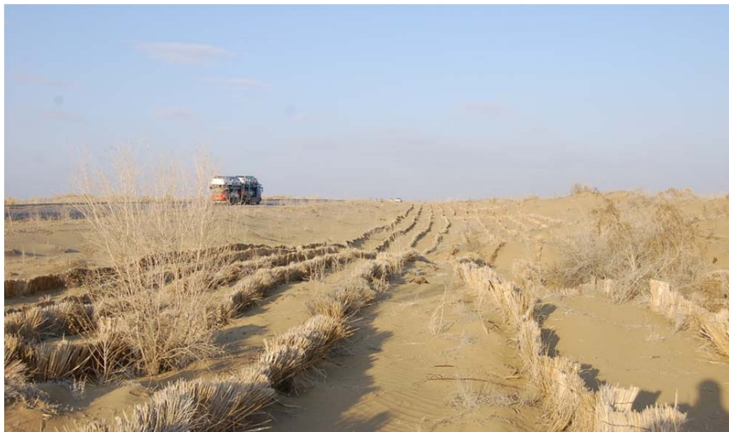
Рисунок 3 – Проведение фитомелиоративных работ с комбинированной установкой рядовых полускрытых механических защит вдоль автомобильной дороги
