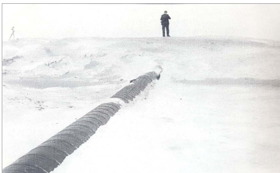
Рисунок 3 – Начальная стадия процесса выдувания газопровода
