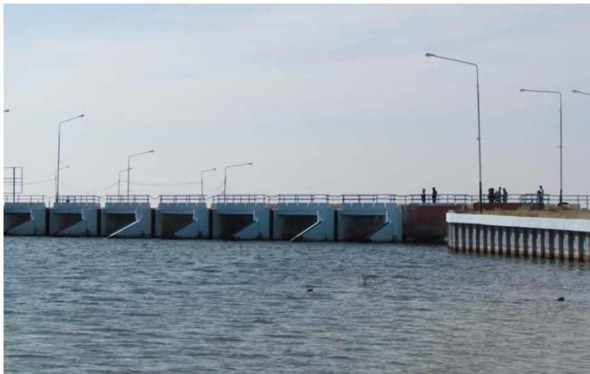
Рисунок 4 – Верхний бьеф водосбросного сооружения Кокаральской плотины САМ
