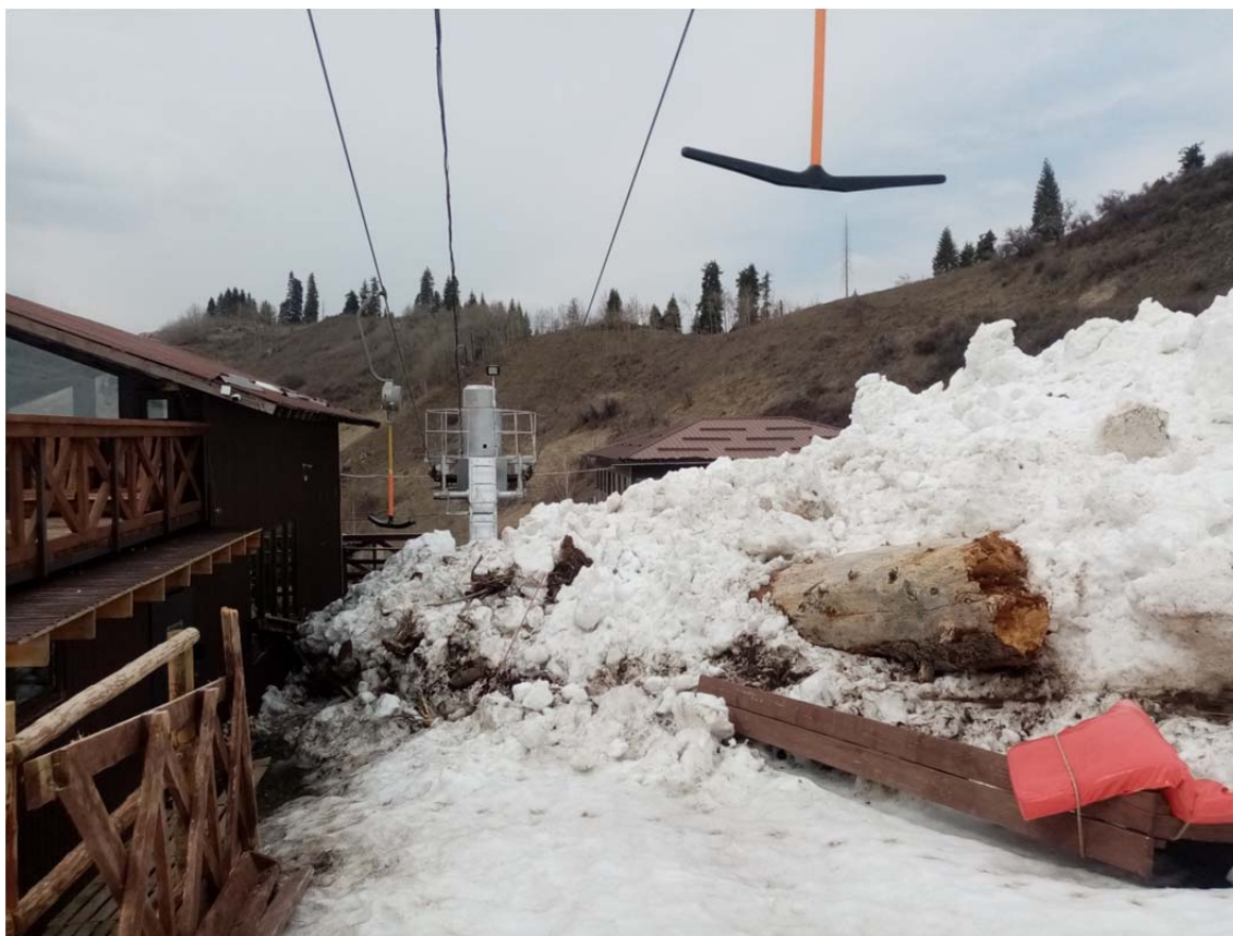
Рисунок 1 – Последствия схода снежной лавины в районе горнолыжной базы «Пионер» в марте 2024 г.
